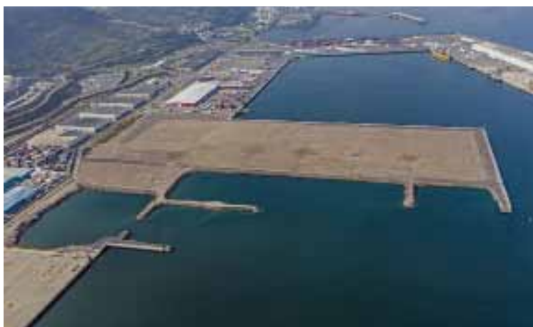
Entre otras actuaciones, destaca el inicio de la urbanización de la 1ª fase del Espigón Central.
